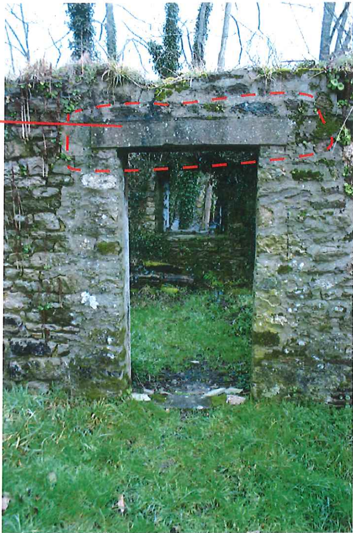
Linteau en béton à démolir et remplacer par un linteau en bois massif
