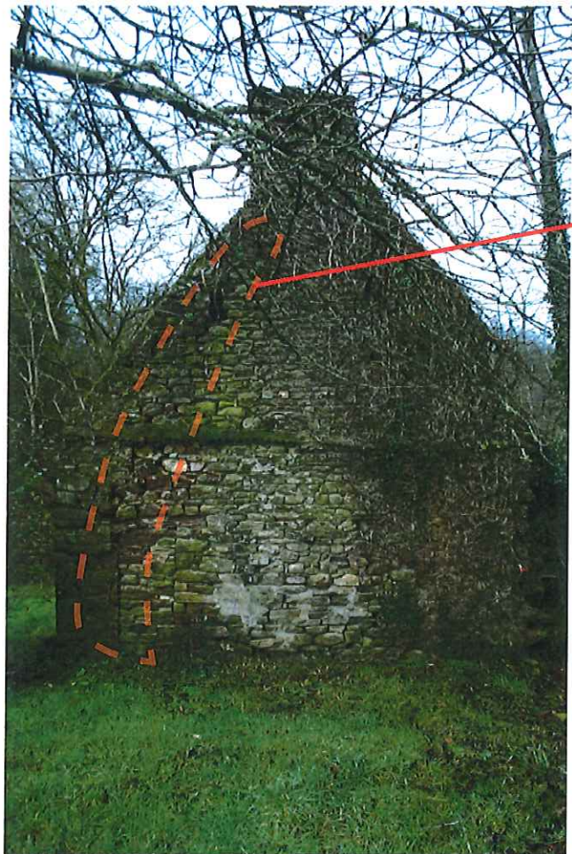
Stabilisation et reprise d'empierrement à réaliser
