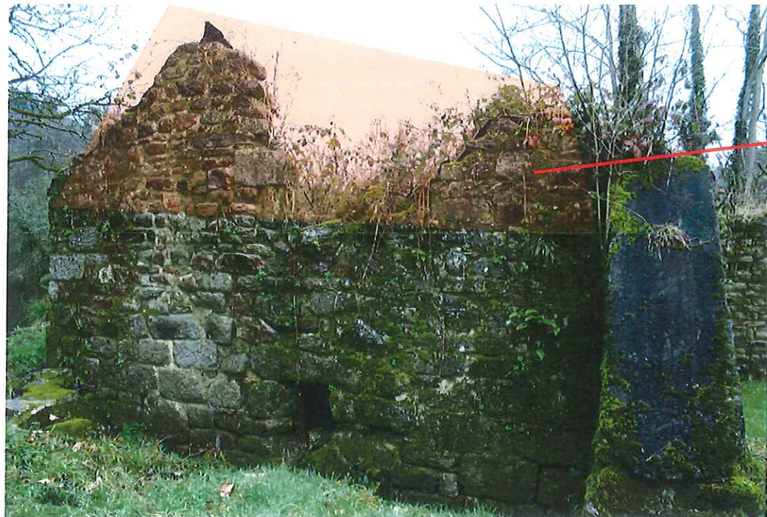
Partie de murs à démonter afin de mettre en sécurité le site
