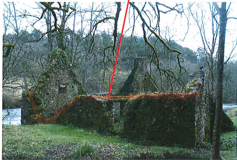
Arases de murs à démolir et reconstruire afin de parfaire la sécurité et l'étanchéité.
