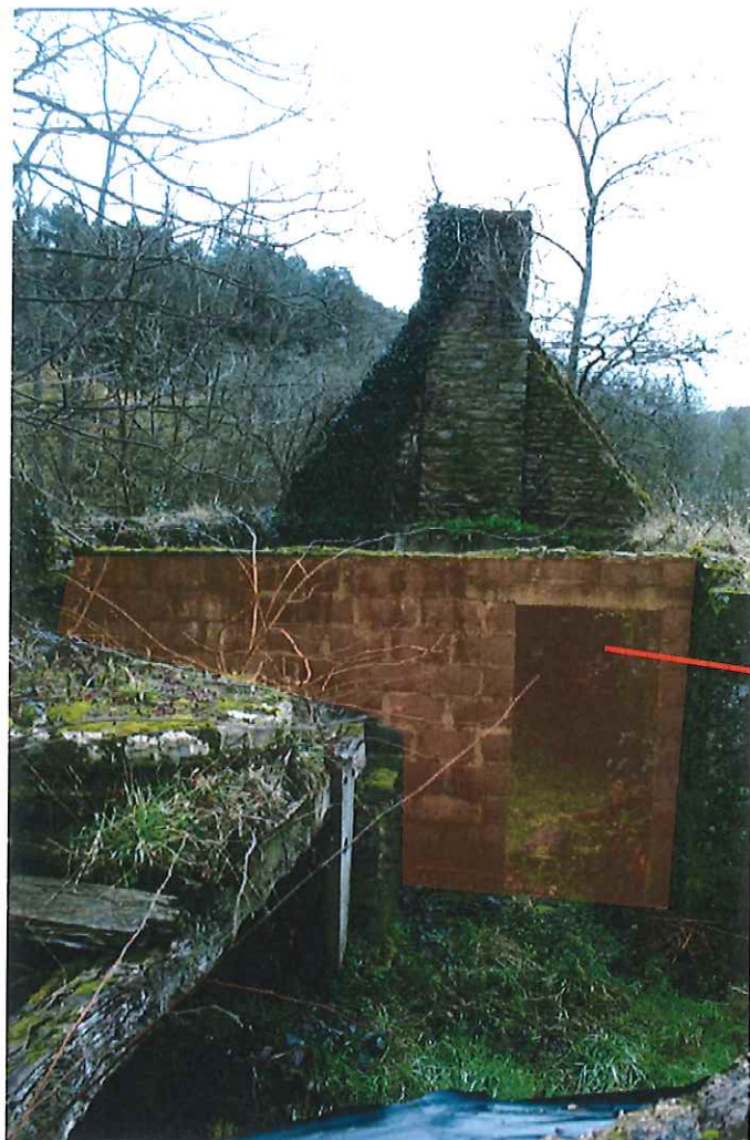
Mur en maçonnerie de parpaing à démolir
