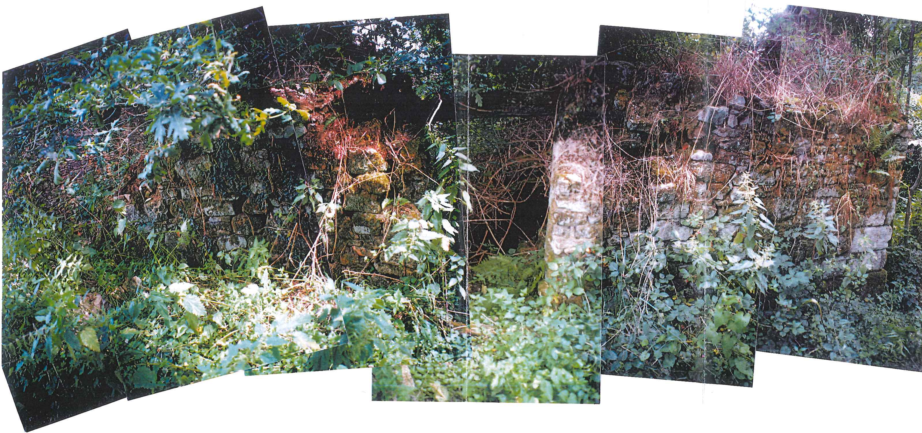
Maçonnerie du mur Nord-Ouest
