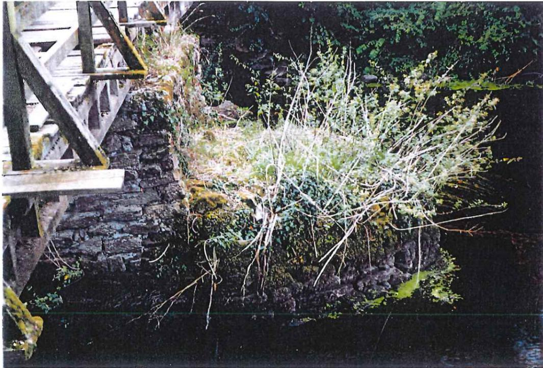
La pile centrale et l'avant-bec amont
